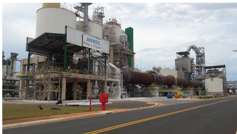
18 The world's largest lime kiln at Eldorado Três Lagoas mill.
